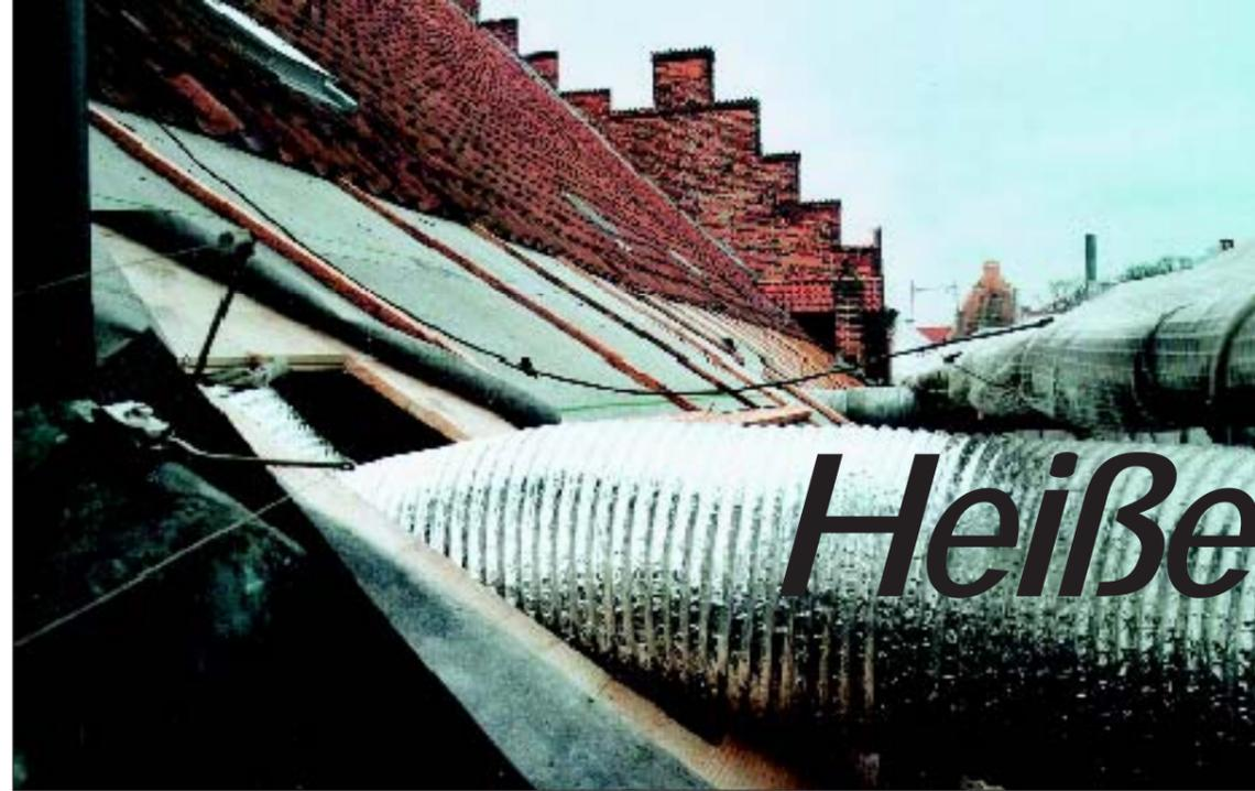
Für die Heißluftrohre wird das Dach ein letztes Mal geöffnet, bevor es für hoffentlich lange Zeit dicht bleibt
